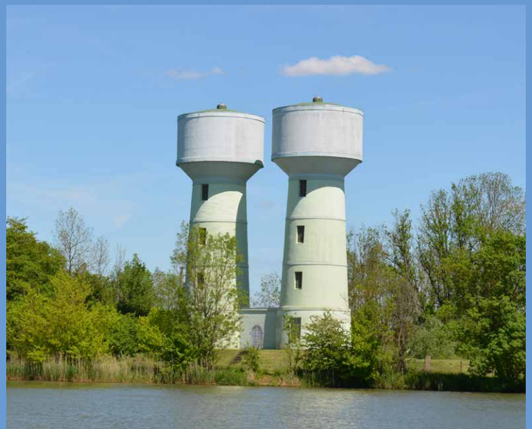
▲ Le Réservoir des Pointes à Auxonne où sera installée l'unité de filtration
